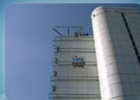
Платформы ALTA, с монорельсом RAILSCAF, Франция
