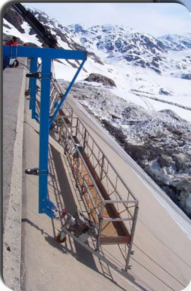
Двухуровневая платформа ALTA с лебедкой для погрузо-разгрузочных работ (мраморные плиты) и дополнительной персональной люлькой, Саудовская Аравия
