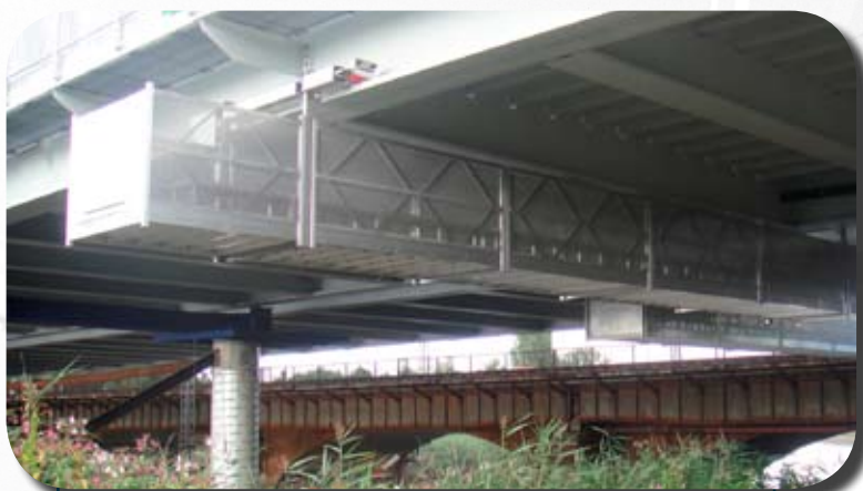
Переходная платформа для ремонта моста 15м, Бельгия
