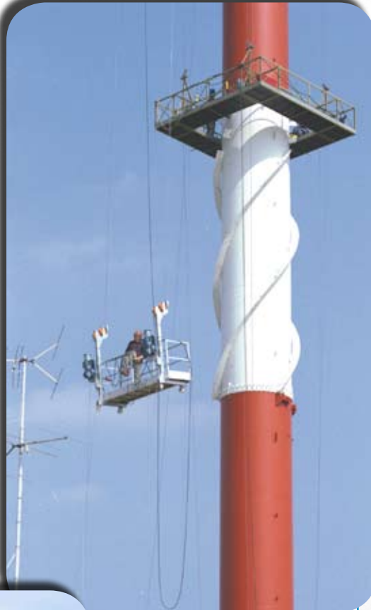
Платформа ALTA специально сконструированная для обслуживания антенны, Германия
