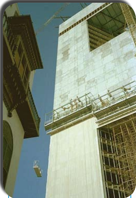
Двухуровневая платформа ALTA с лебедкой для погрузо-разгрузочных работ (мраморные плиты) и дополнительной персональной люлькой, Саудовская Аравия
